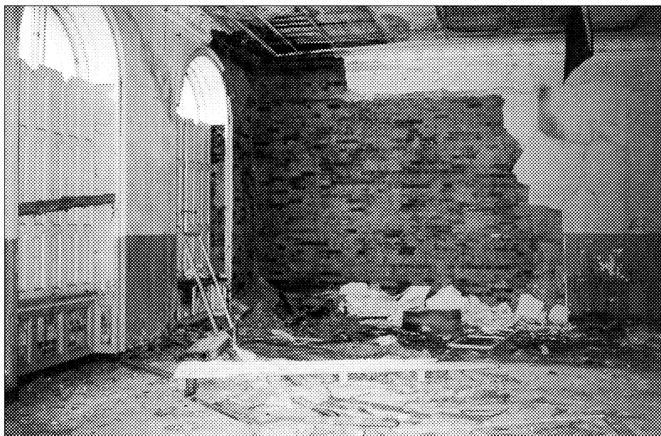
5. Sala balowa – widok z 1998 roku.
